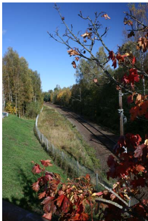
Hovedbanen, sør for stasjonen
