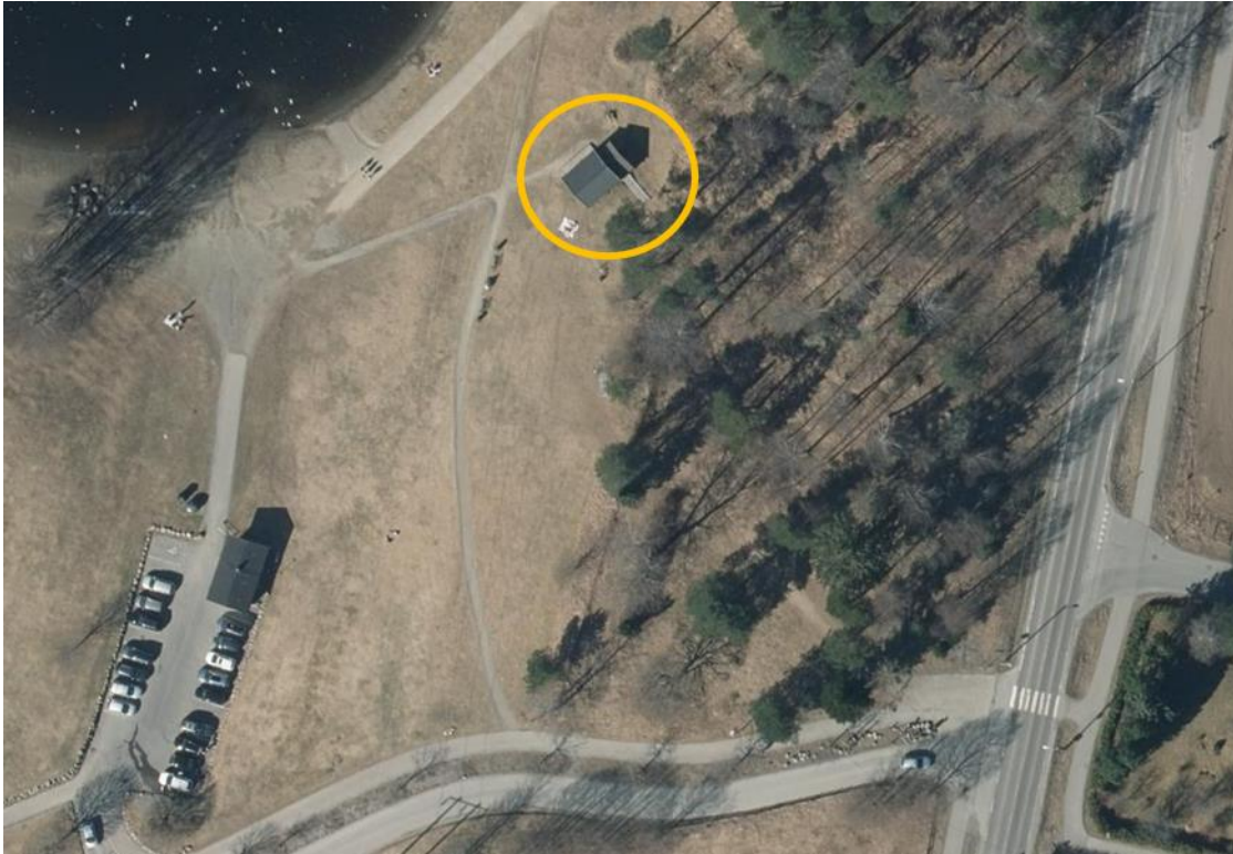
Bilde 5. Viser område hvor dagens toalettbygg er plassert.
