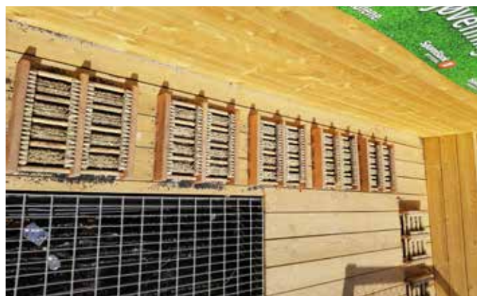
Bilde 4 og 5: Rist over betonggrav og koster til å børste av seg granulat. Li idrettsanlegg, Nittedal april 2019.
