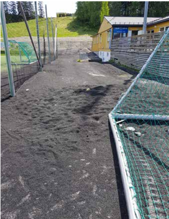
Bildene 148, 149, 150 og 151 På Skjetten stadion var det under befaring store mengder granulat over alt rundt banen.
