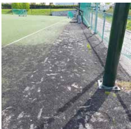
Bilde 97, 98 og 99: Bilder av granulater utenfor banen og mulig snølager.
