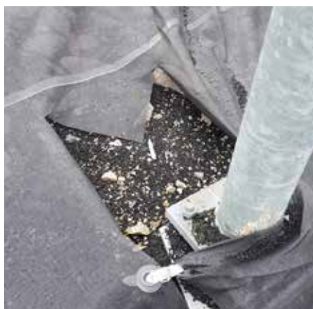
Bilde 53, 54 og 55: Bilder av granulat under dekkduken, langs gangvei og av gjennomført tiltak for å unngå spredning.
