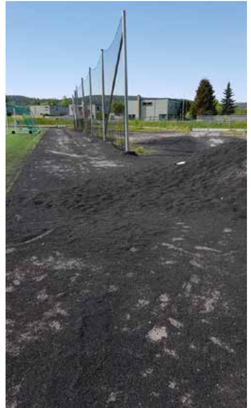
Bildene 148, 149, 150 og 151 På Skjetten stadion var det under befaring store mengder granulat over alt rundt banen.
