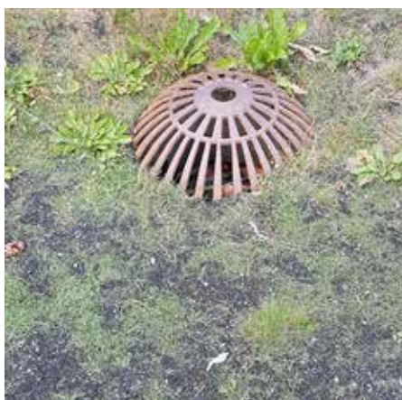
Bilde 74, 75 og 76: Bilder av granulat utenfor banen og tett opp til kum.
