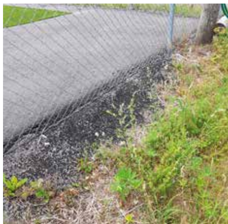
Bilde 65, 66 og 67: Bilder av granulat utenfor banen, og sekker fulle med granulat som har sprekt.
