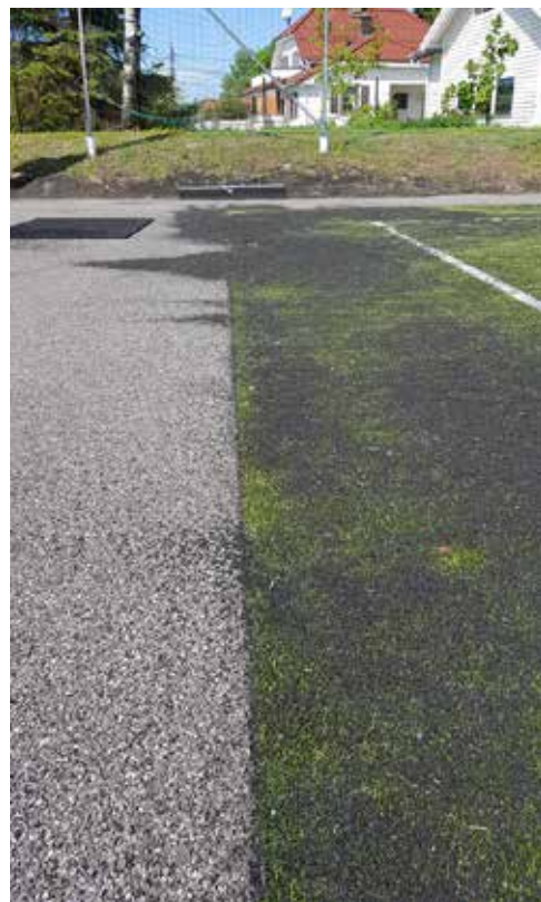
Bildene 144 og 145 viser granulat som har hopet seg opp langs kantene av kunstgressmatta.
