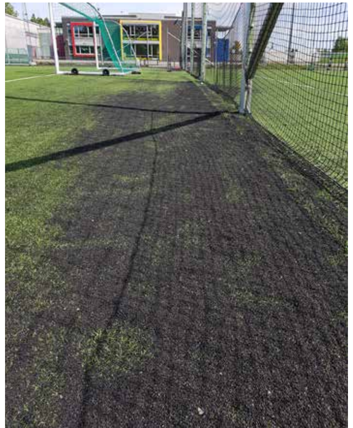
Bildene 148, 149, 150 og 151 På Skjetten stadion var det under befaring store mengder granulat over alt rundt banen.
