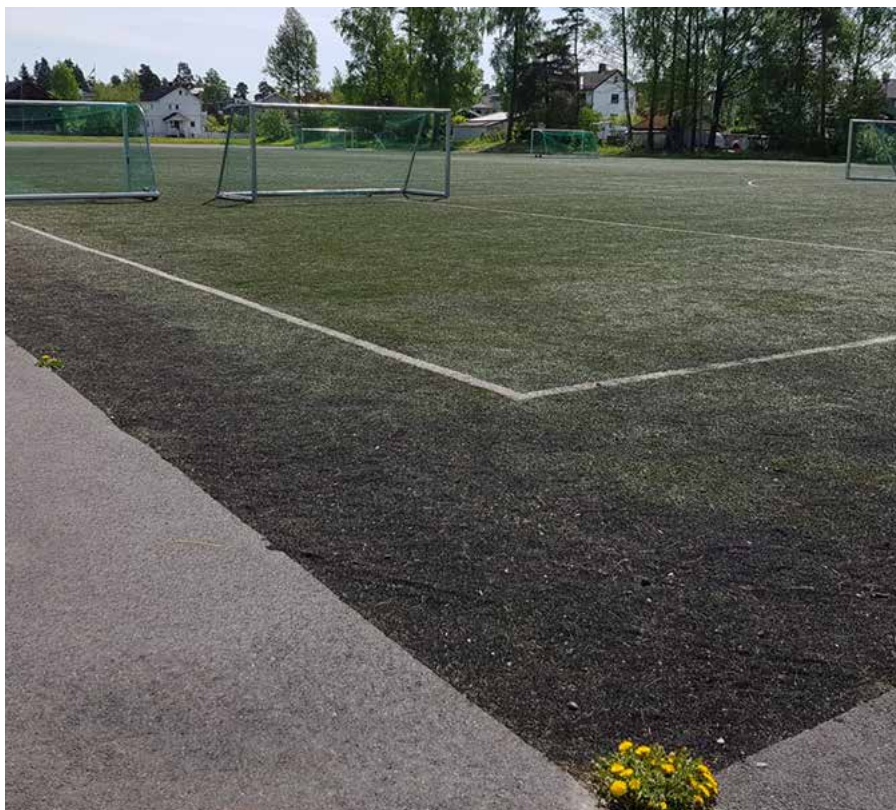
Bildene 144 og 145 viser granulat som har hopet seg opp langs kantene av kunstgressmatta.
