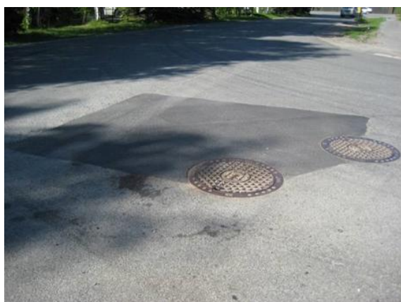
Eksempler på feil (bilde til venstre) og riktig utførelse (bilde til høyre) av skjæring av asfalt rundt kummer.
