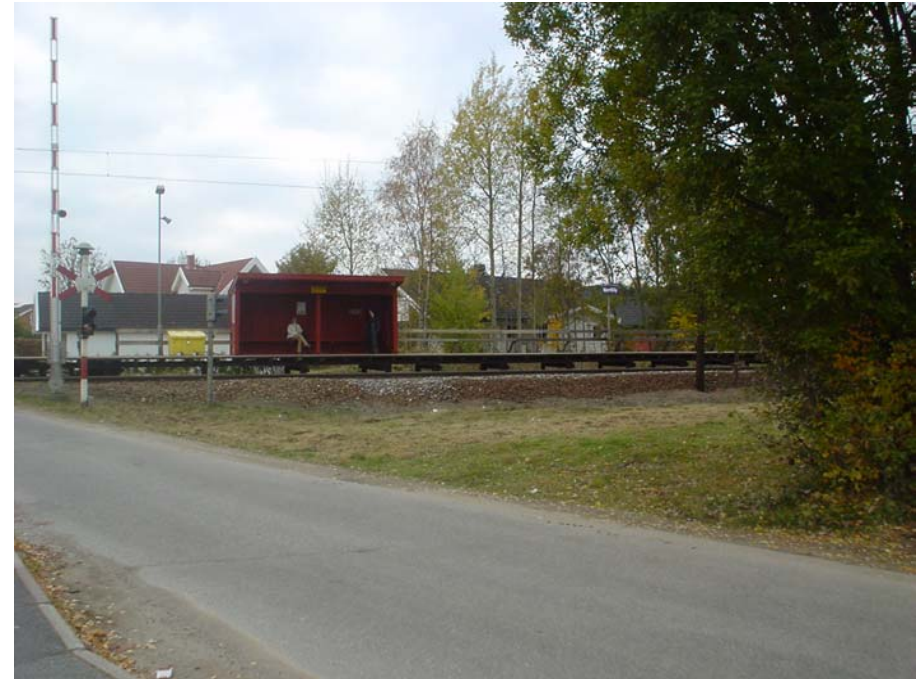
Figur 6-4: Nordby stasjon – sykkelparkeringsplasser skal etableres sommeren 2005.
