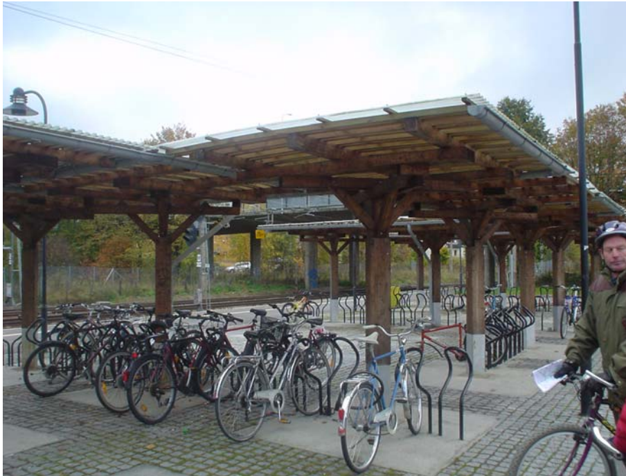
Figur 6-3: Sykkelparkering under tak ved Jessheim stasjon
