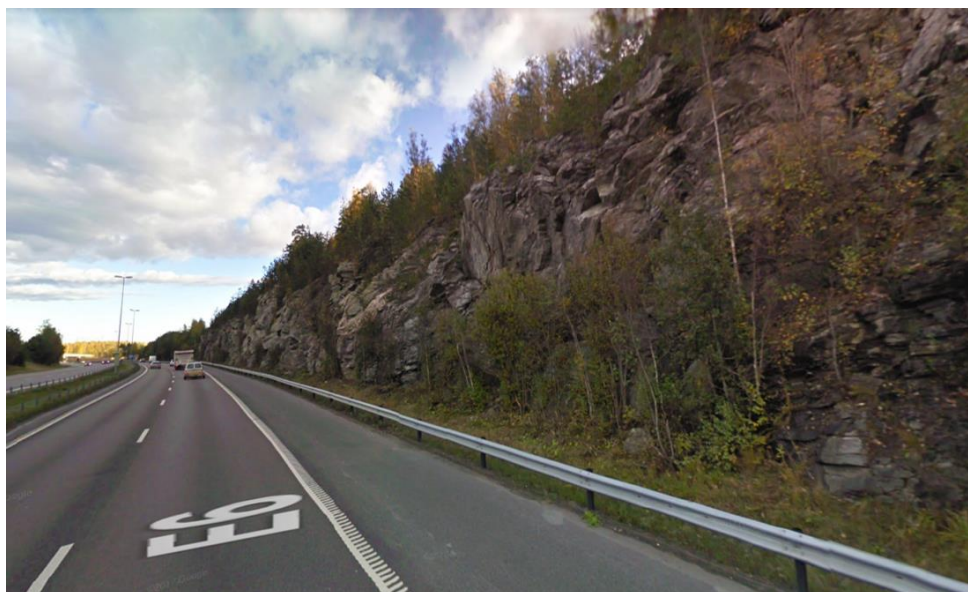
Fjellskjæring ved E6 med planområdet B8 til høyre
