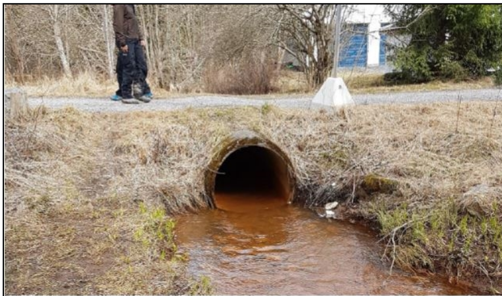
Kulvert der Gamle Algarheimsveg krysser Pinnebekken (Kilde: Norconsult).
