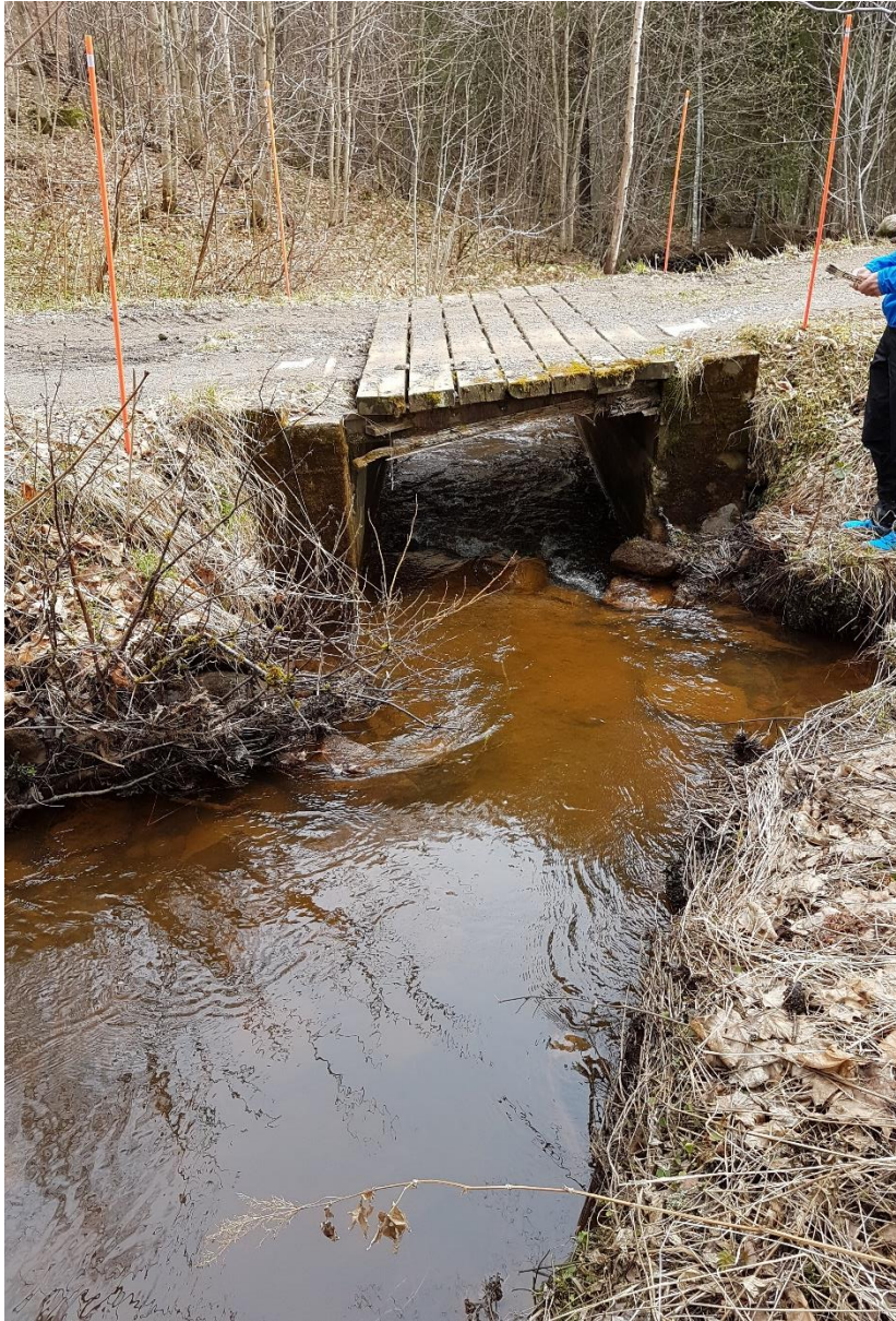
Figur 5 Kulvert under Brattfossvegen
