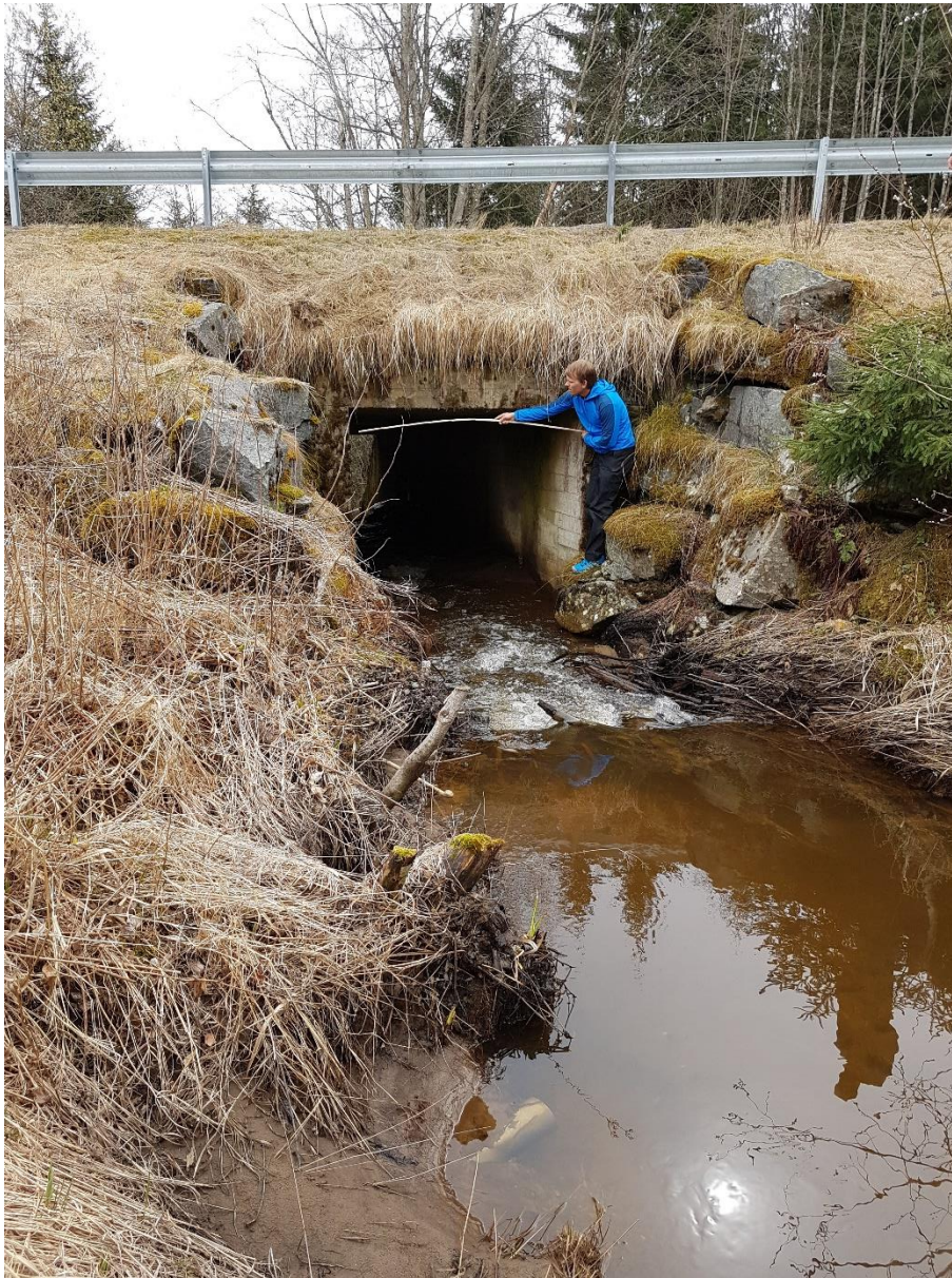
Figur 6 Kulvert under Åsvegen
