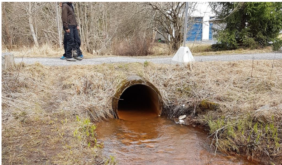
Figur 2 Kulvert der Gamle Algarheimsveg krysser Pinnebekken
