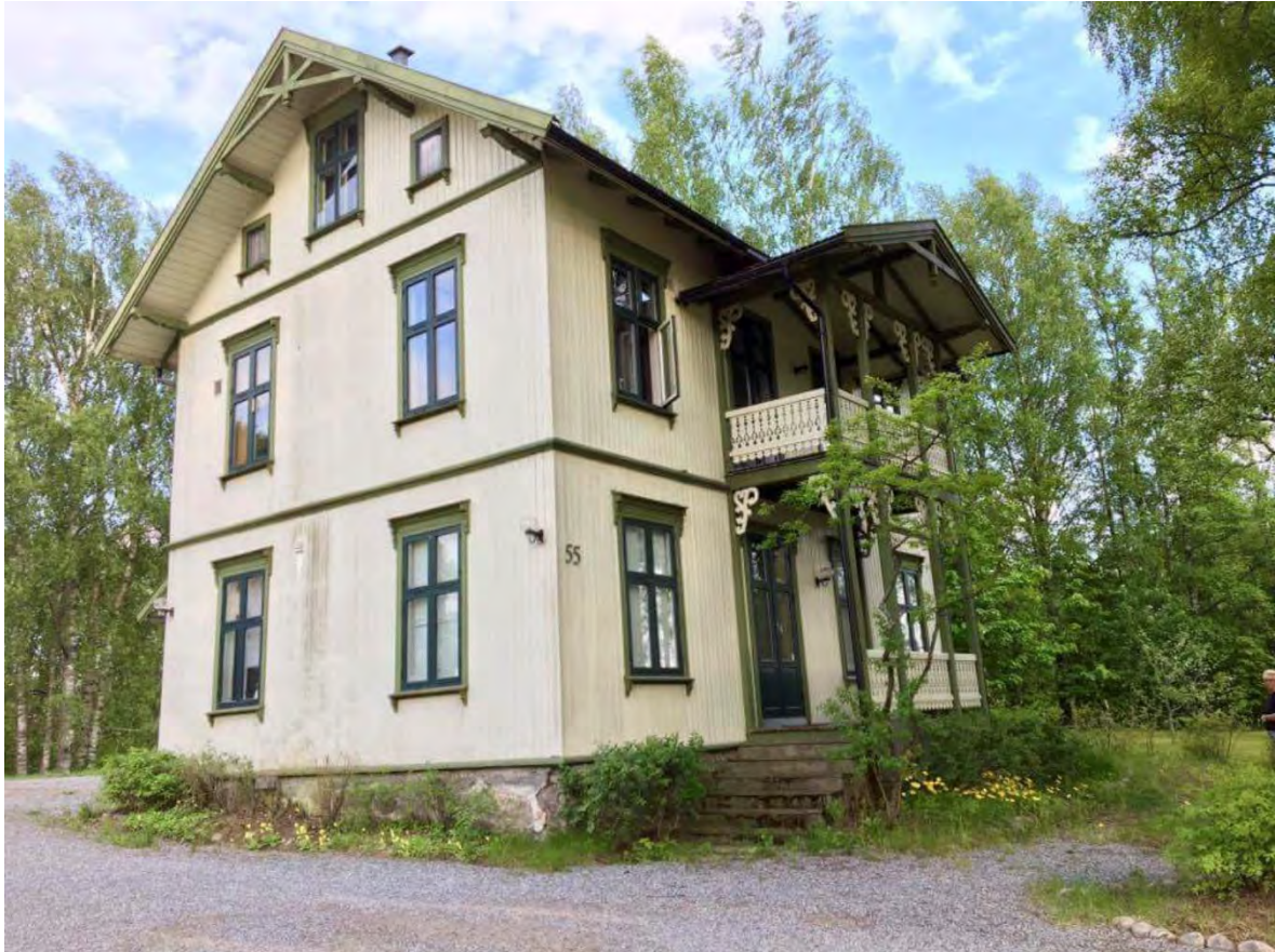
Hovedhus sett fra gårdsplassen
