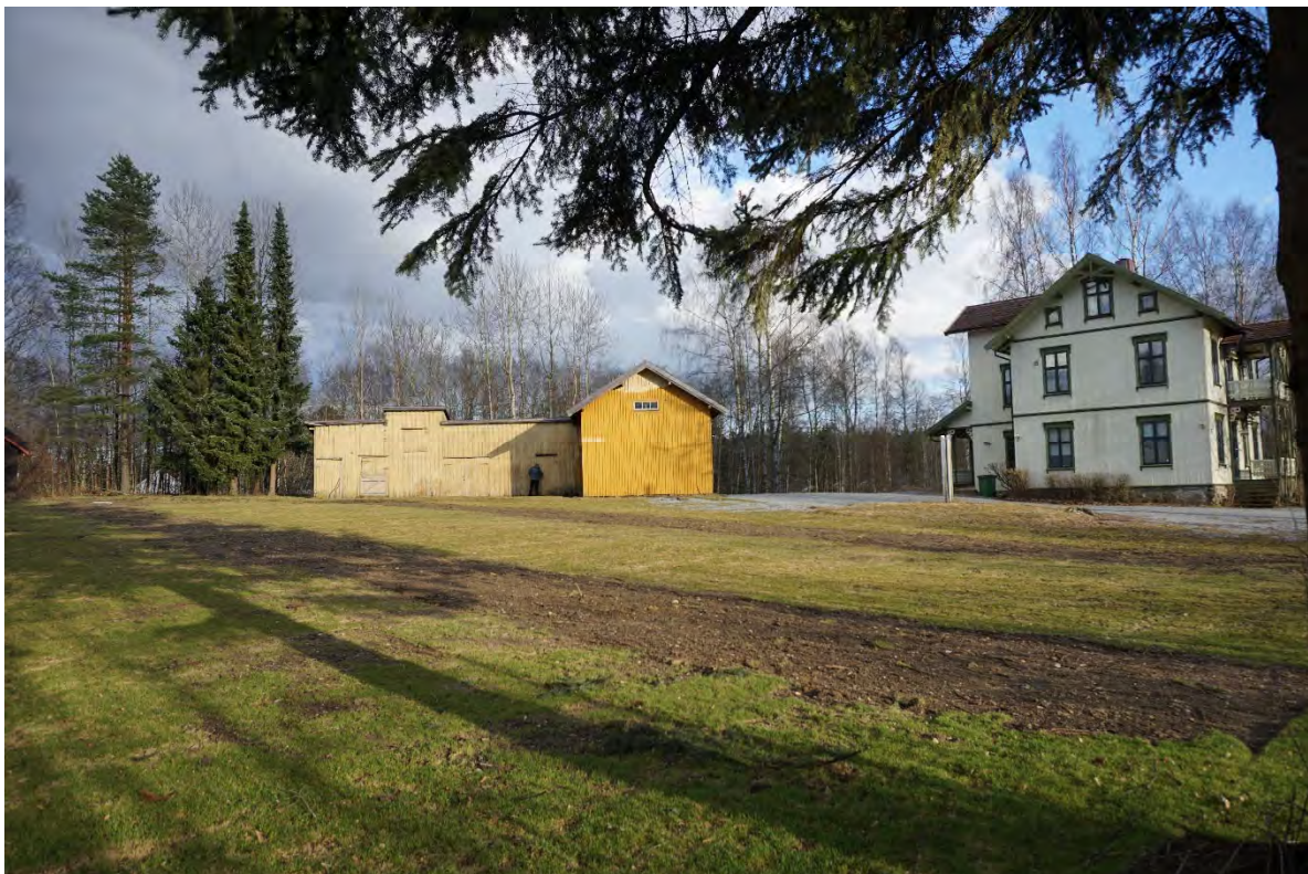
Hage og bebyggelse sett fra nordvest (fra Trondheimsvegen)
