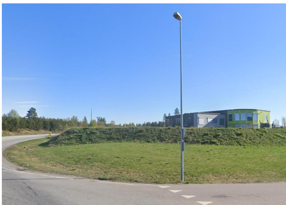
Figur 7: Viser eksisterende støyvoll mellom rv. 174 og barnehagen, sør for planområdet. Eksisterende støyvoll ligger tett ut mot veien, da støyskjerming er mest effektiv i nærheten til kilden.
