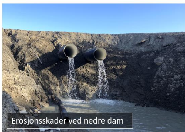
Figur 3 Bilder av erosjonsskader ved nedre dam og i bekkeløpet nedstrøms hotellet.
