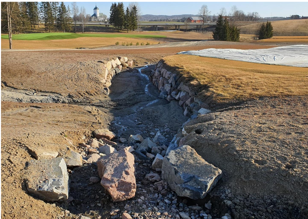
Figur 12 Påbegynt bekkeløp mellom nytt hotell og dammer på golfbanen.
