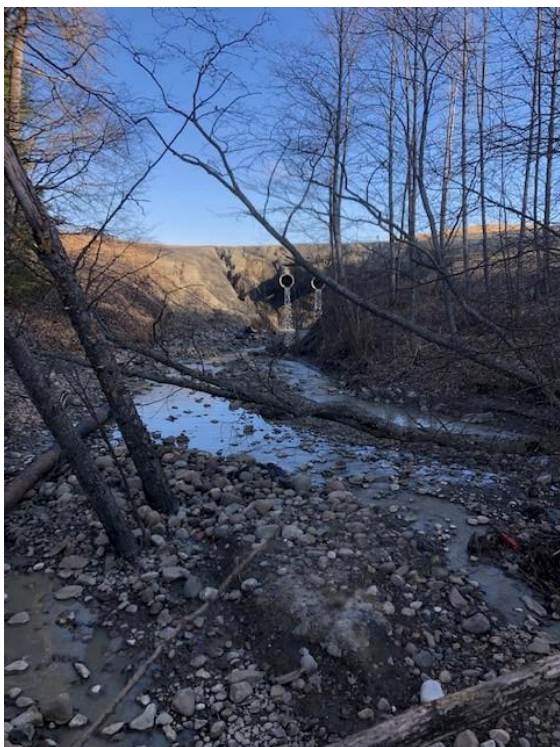
Figur 16 Bekkeløp nedstrøms fylling ryddes ifm. erosjonssikring.
