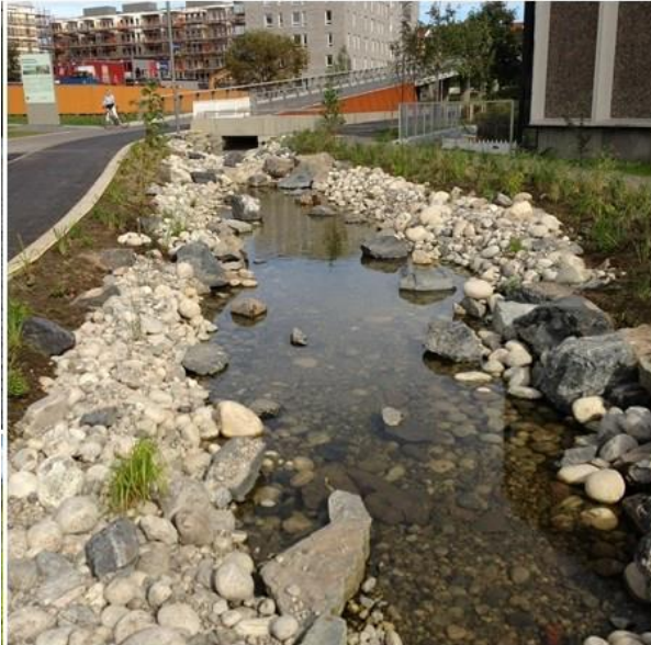
Bilde 1. Eksempel på åpen overvannshåndtering fra Strategi for overvannshåndtering i Oslo (2013-2030) . Foto: C. Bråthen, Vann- og avløpsetaten, Oslo kommune.
