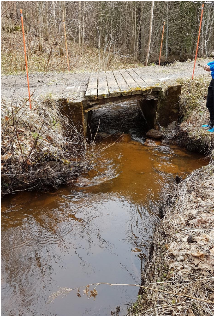
Figur 4 Kulvert under Brattfossvegen.
