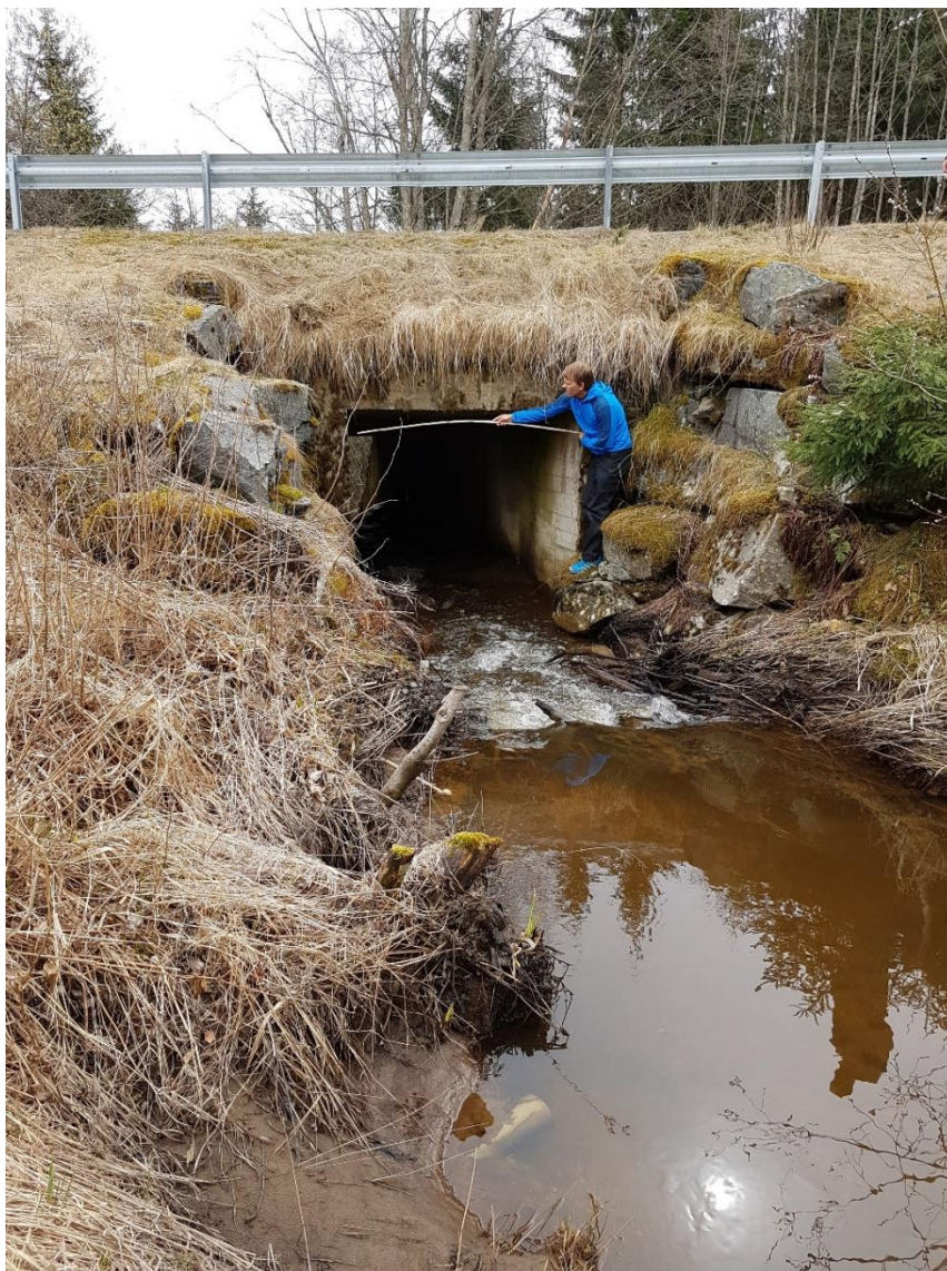
Figur 5 Kulvert under Åsvegen.
