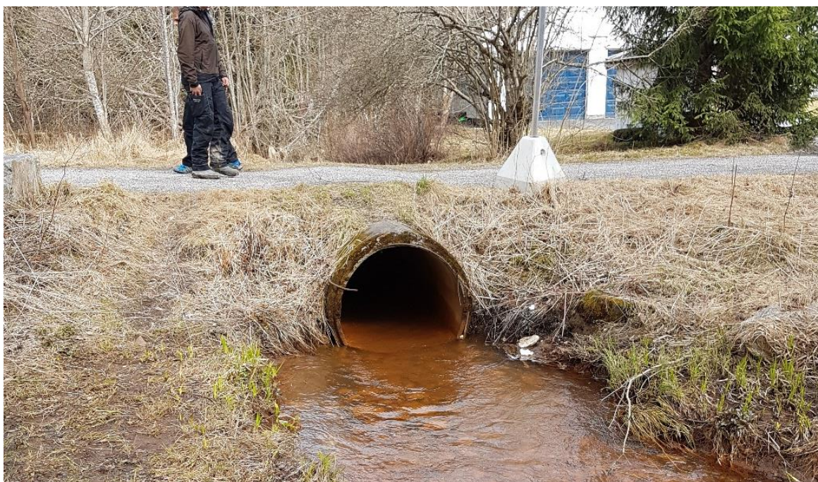
Figur 2 Kulvert der Gamle Algarheimsveg krysser Pinnebekken.
