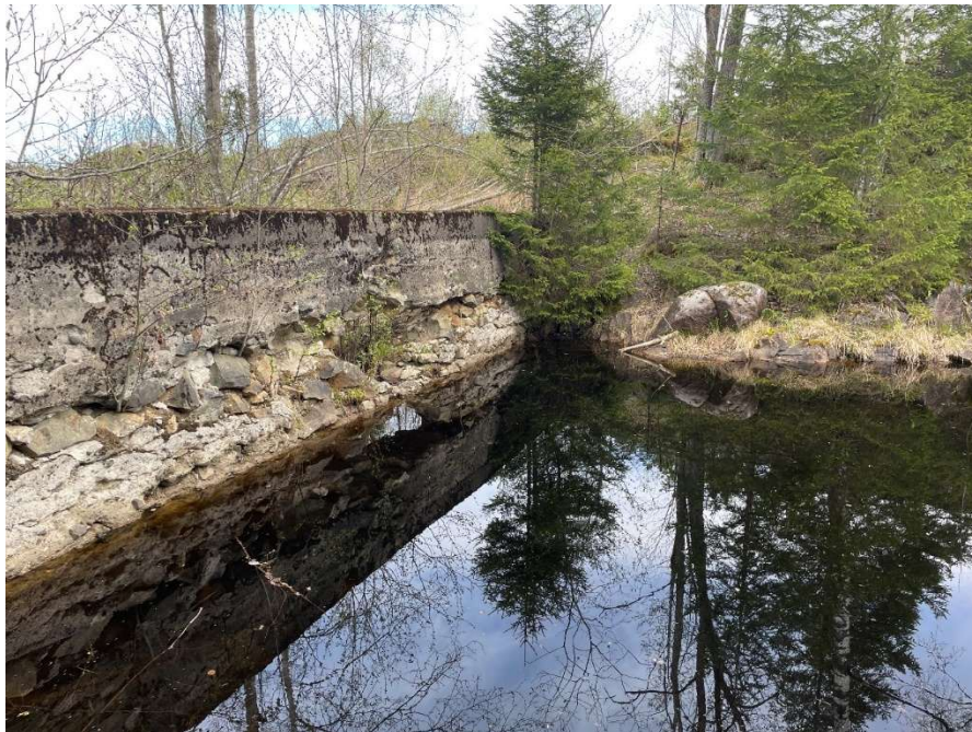
Figur 4 - Bilde av demningen og det åpne vannspeilet. Dammen er opptil 2 meter dyp, og har mulighet for ytterligere fordrøyning.
