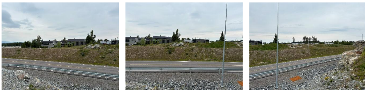
Figur 12 - Utsyn til eksisterende bebyggelse fra dages grusveg til vannforsyningsanlegget, ca. 6 meter over Ole Korslunds veg
