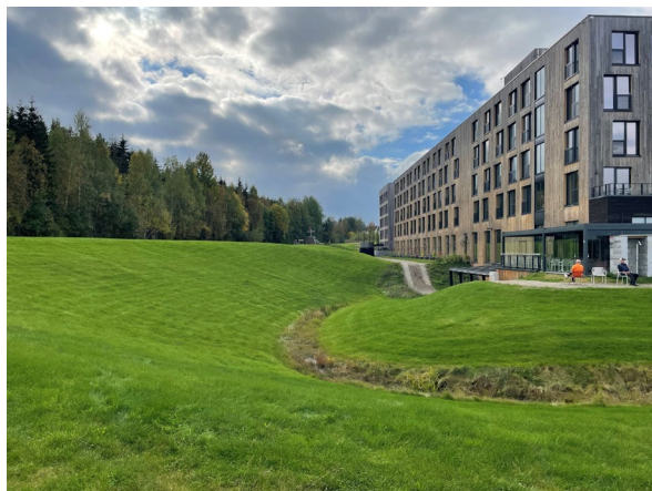
Terrengskål sett fra nord
