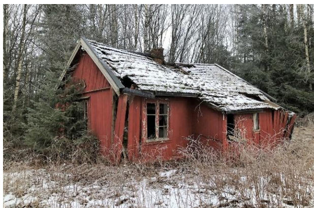
Stuebygning på Mogreina som har gått ut av bruk.
