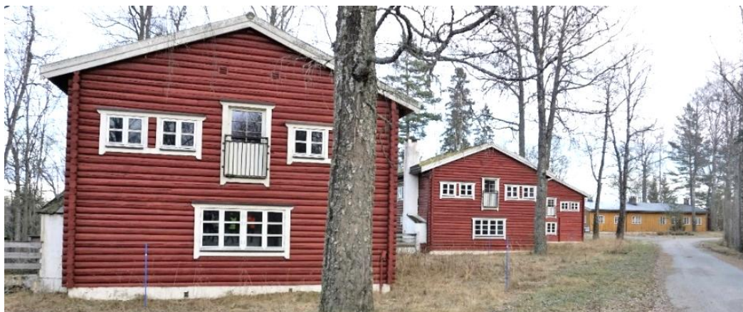
Trandum militærleir ble nedlagt på grunn av etableringen av hoved-flyplassen. I dag jobbes det med å sette i stand og skape ny aktivitet i bygningene.
