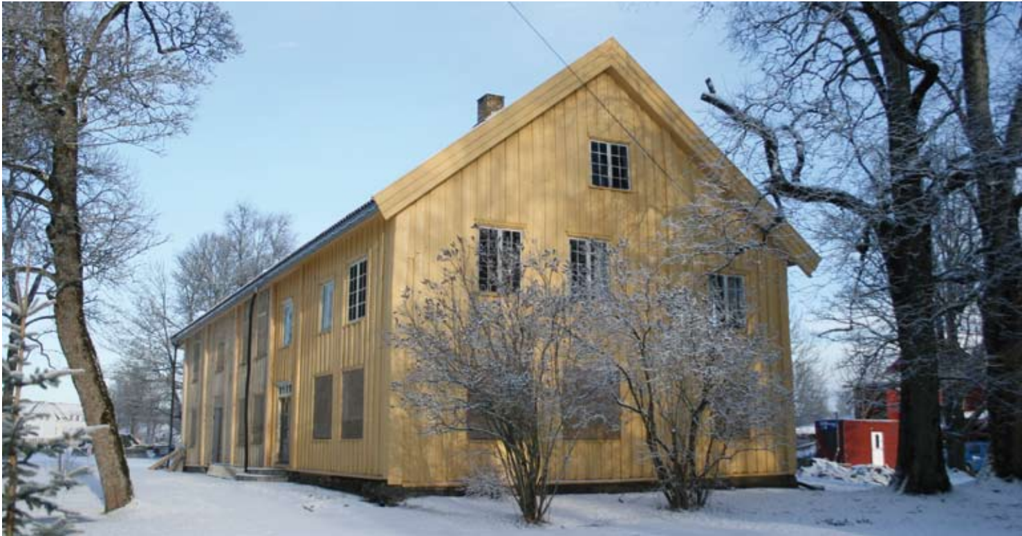
Skrivergården Hovin, Hvor Christiane Koren skrev sine berømte dagbøker. Huset er den eneste privateide fredede bygningen i Ullensaker. Bildet er tatt mens restaureringen pågikk. Foto Ola H Fjeldheim, Ullensaker kommune
