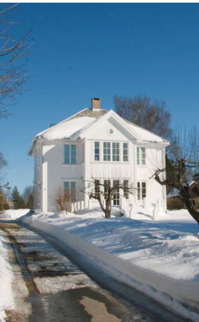
Trondheimsvegen 59 på Jessheim mistet mange av sine opprinnelige detaljer i en tidligere ombygging. Eierne har nå rehabilitert huset med mål om å få tilbake et utseende tilsvarende det opprinnelige. Foto Ola H Fjeldheim, Ullensaker kommune
