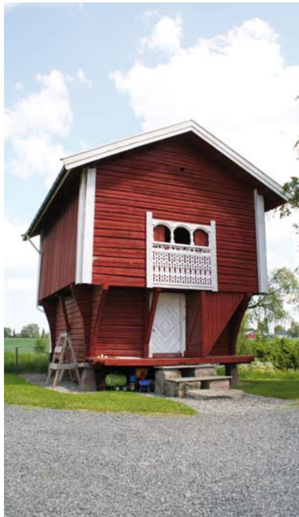
På Nordre Olstad er det opprinnelige rettveggede stabburet blitt bygget om, ved at en ny laftet etasje er blitt satt under den eldre delen. Partiet med telemarksinspirert dekor er satt inn for å skjule den opprinnelige døråpningen. Ombyggingen er trolig gjort litt etter 1900, og viser at brukeren ønsket å følge tidens mote. Foto Ola H Fjeldheim, Ullensaker kommune
