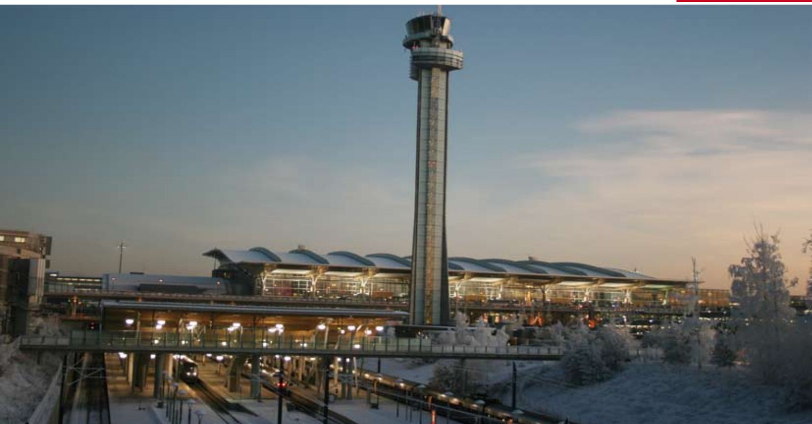
Flyterminalen og tårnet på Gardermoen gir tydelig uttrykk for hvilken tid de er bygget i. Begge vil bli fredet av Riksantikvaren som kulturminner. Foto Ola H Fjeldheim, Ullensaker kommune
