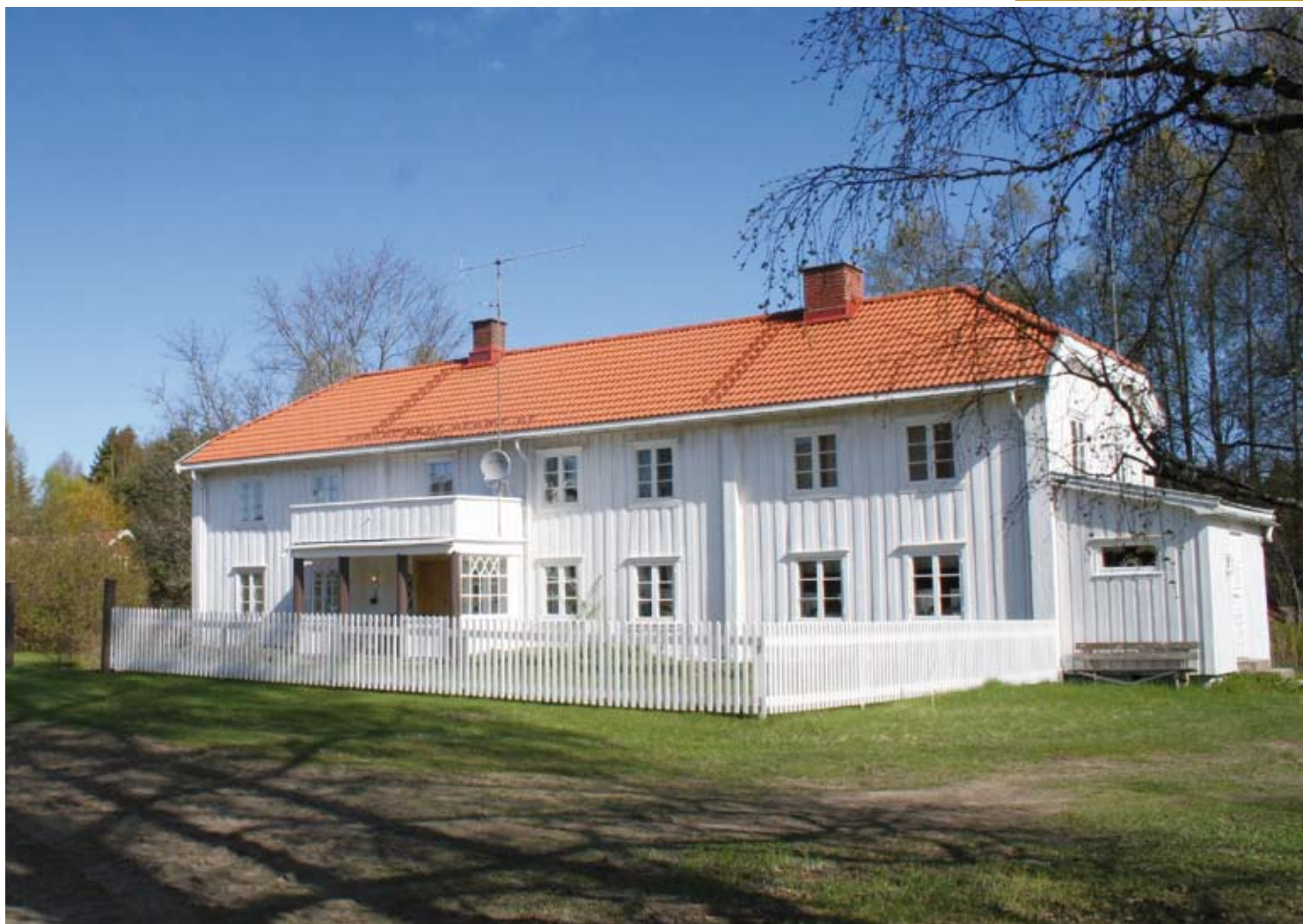
Hovedbygningen på Majorseter, Ullensaker kommune Foto Ola H Fjeldheim,
